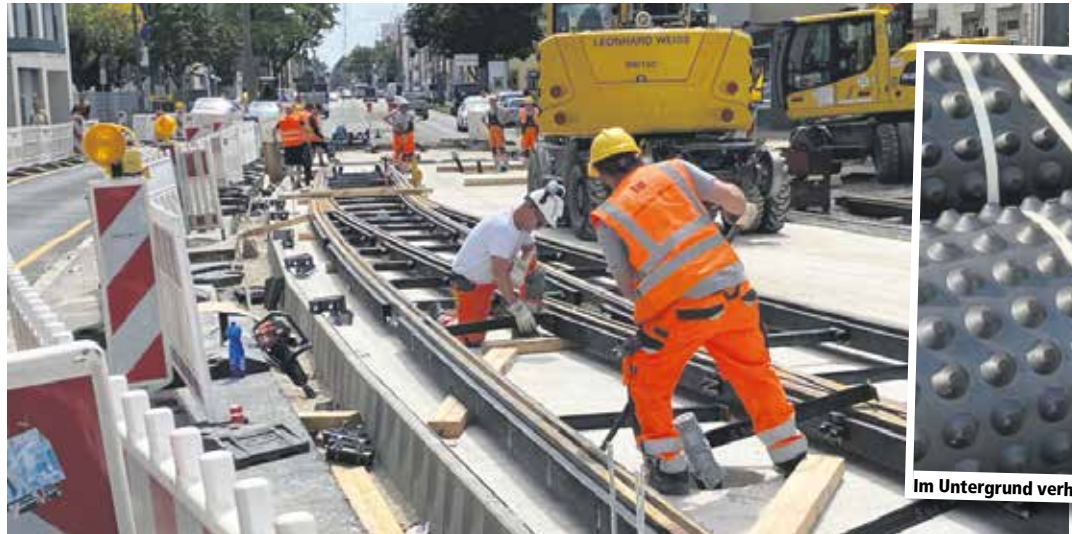
In Weidenpesch wurde der erste Teil einer umfangreichen Weichenanlage eingebaut
