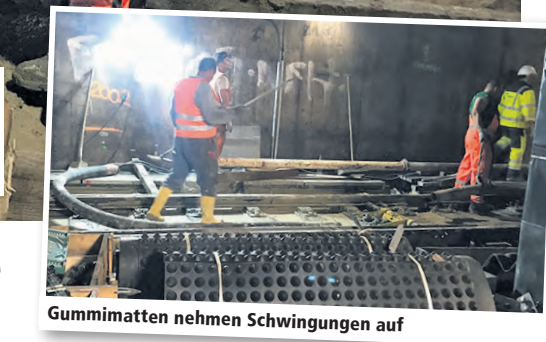
Gummimatten nehmen Schwingungen auf
