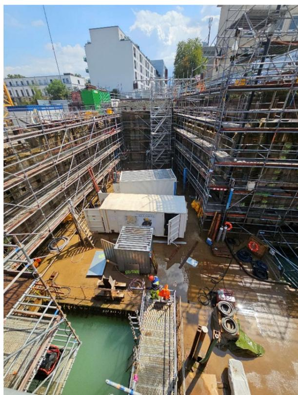
Die Baugrube muss im weiteren Bauverlauf aus statischen Gründen mit Kies verfüllt werden. Vorbereitend wurden sogenannte Schütttürme errichtet, über die der Kies eingebracht wird. Der Aufbau der Türme ist abgeschlossen, so dass die geplante Verfüllung zügig durchgeführt werden kann.
