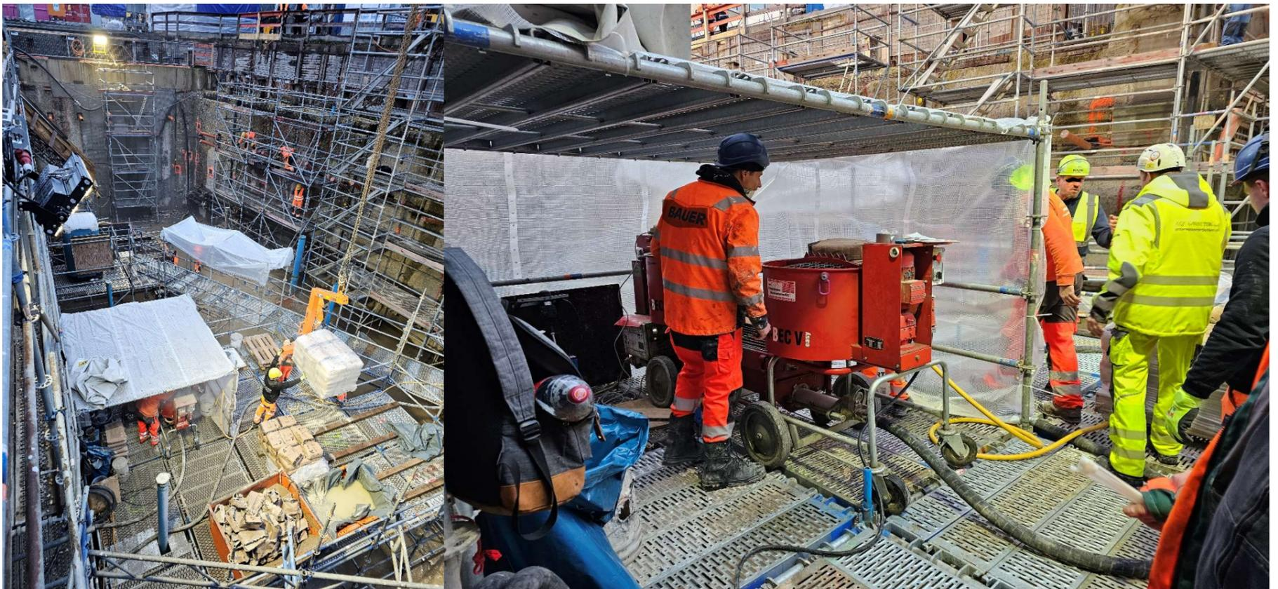
Der Spalt zwischen der bereits hergestellten Betonschicht unterhalb der Zwischendecke wird mit Betec 140 (Vergussmörtel) drucklos verfüllt.
