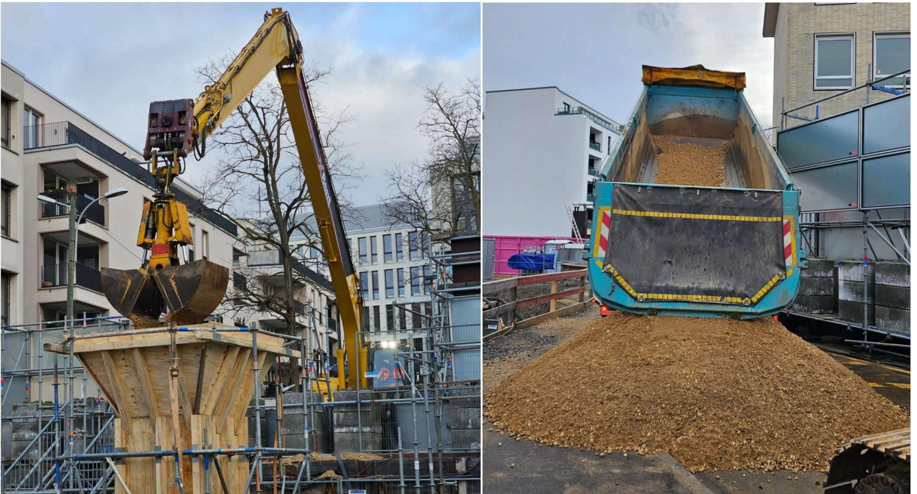
Die Verfüllung des mittleren Stockwerks des Gleiswechselbauwerks Waidmarkt mit Kies läuft auf Hochtouren. Aktuell wurden bereits etwa 70 Prozent der 3.200 Kubikmeter Kies in den komplett mit Grundwasser gefüllten, rund 5,50 Meter hohen Hohlraum eingebracht.
