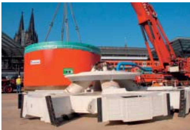
2 Antransport der Schildmaschine am Los Nord mit Blick auf den Kölner Dom
