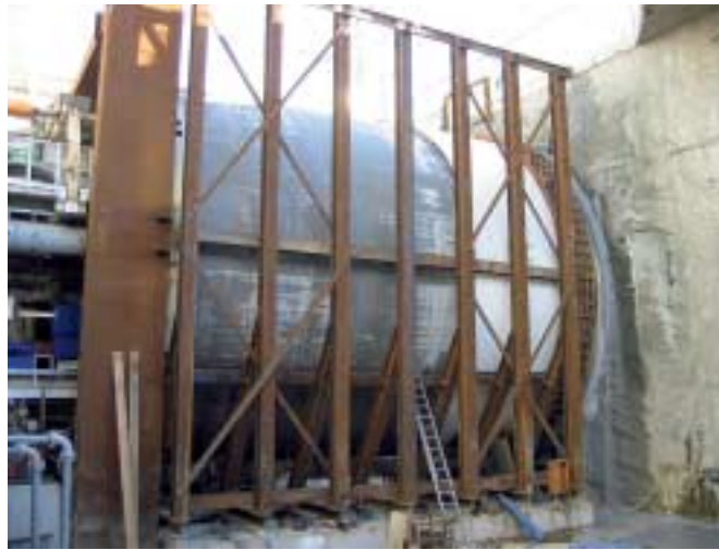
1 Herkömmliche Rücksteifkonstruktion und Blindringabstützung Herrentunnel Lübeck
