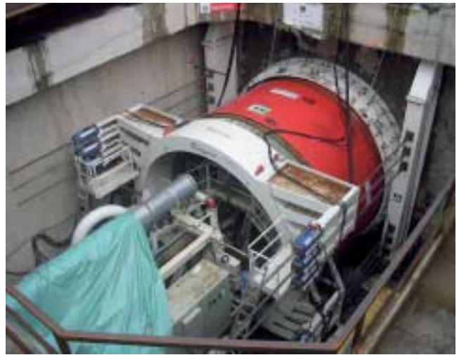
8 Fliegende Schildanfahrkonstruktion und TBM während des Vorschubes
