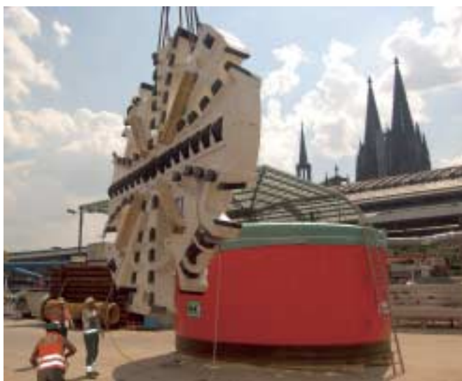
3 Einheben des 6,80 m großen Schneidrades von Los Nord
