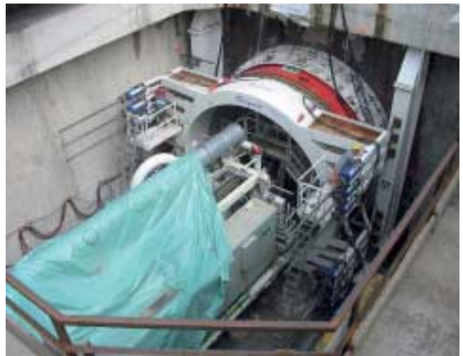
9 Fliegende Schildanfahrkonstruktion in Endstellung
