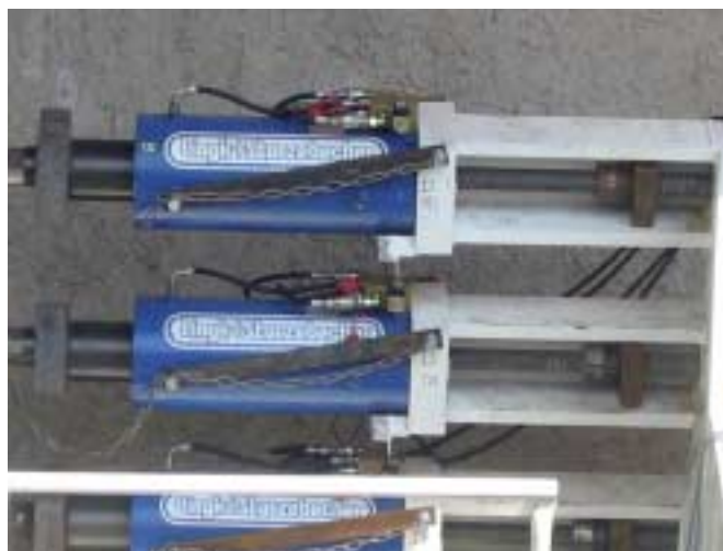
2 Detail Stützbockkonstruktion Druckring mit Hohlkolbenpressen und Ankermuttern
