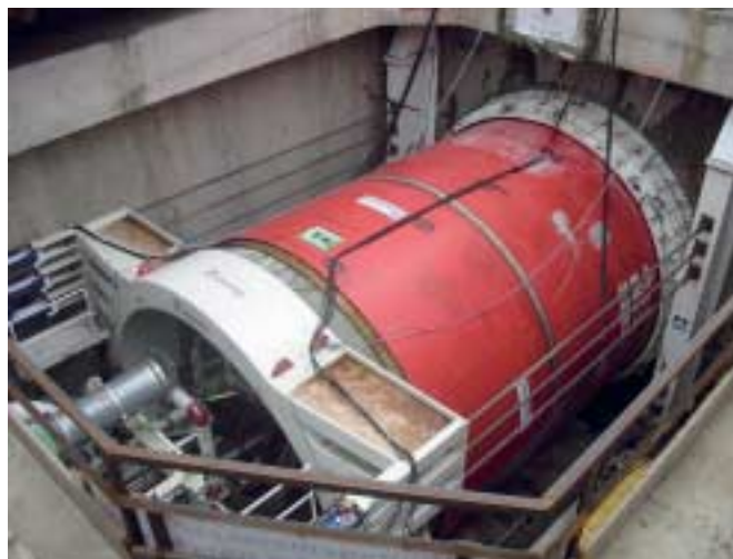
7 Fliegende Schildanfahrkonstruktion und TBM in Startposition Vortrieb Ost
